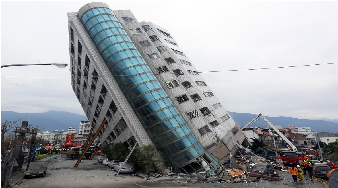
Рис. 3.3.2 Висока будівля після землетрусу
